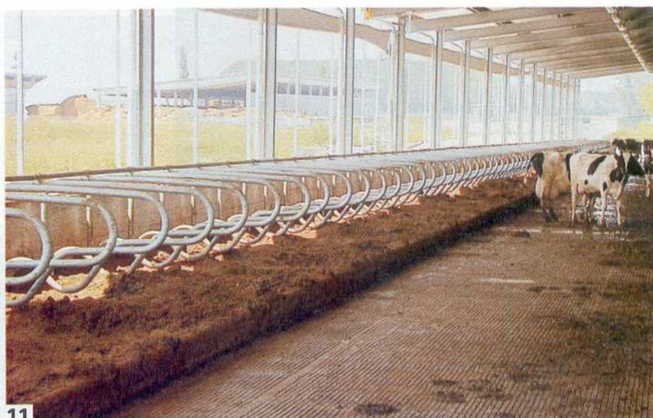
Foto 11 - Rigatura del pavimento mediante la realizzazione di solchi paralleli fra loro e disposti longitudinalmente rispetto all'asse principale della corsia
