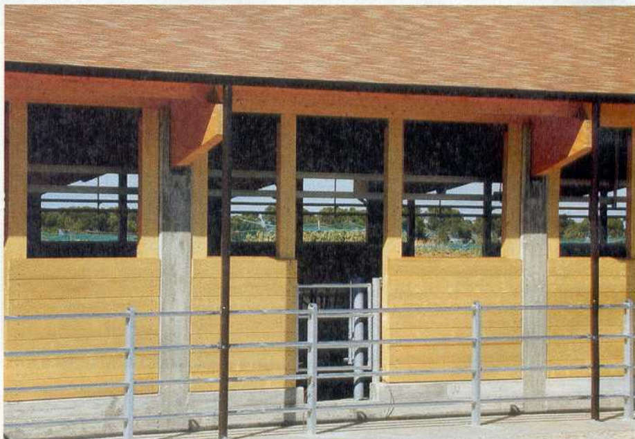
Foto 7 - Tamponamento leggero in tavole di legno
