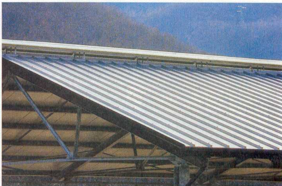
Foto 6 - Ricovero con copertura in pannelli sandwich di lamiera d'acciaio zincata
