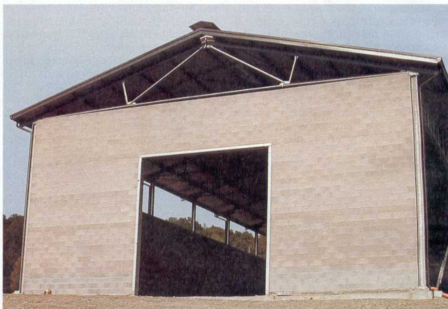
Foto 3 - Struttura prefabbricata d'acciaio a capriata con catena rialzata
