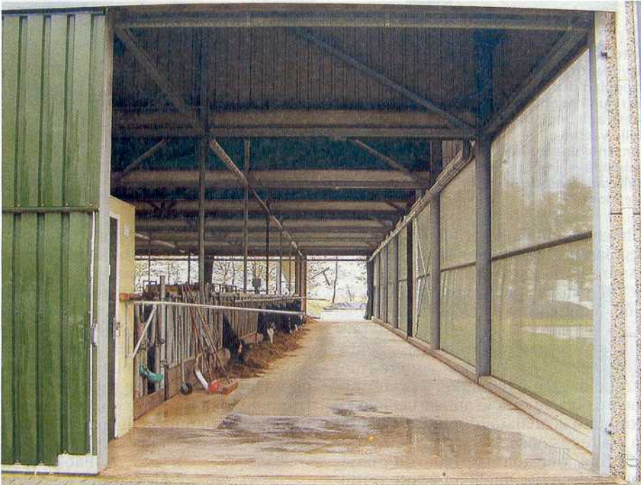
Foto 10 - La rete di materiale plastico installata lungo la parete longitudinale della corsia di foraggiamento di questa stalla per vacche da latte consente di proteggere gli animali dall'aria fredda d'inverno e di ventilare al massimo d'estate
