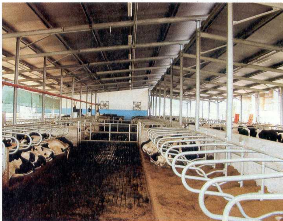
Foto 2 - Esempio di struttura prefabbricata d'acciaio con pilastri rompitratta collocati in posizioni che non sono di intralcio all'animale e all'uomo
