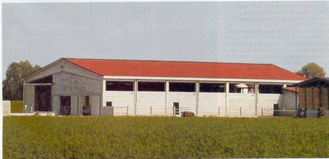
Foto 1 - La tipologia con travi a boomerang, grazie a una pendenza di falda del 20-25%, risulta decisamente la struttura di calcestruzzo armato più adatta per un impiego zootecnico
